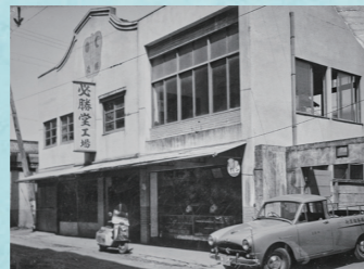
昭和30年頃の外観
